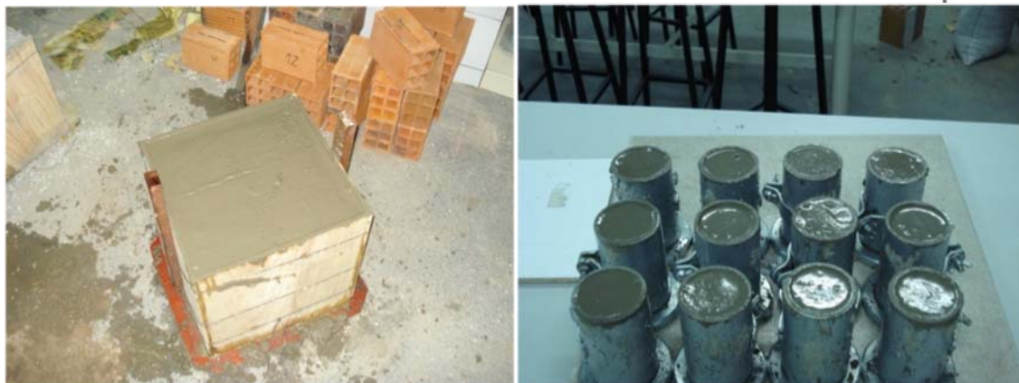
Fig.03. – (a) Concretagem da caixa para testes termo-acústicos (b)- Moldagem dos corpos-de-prova
